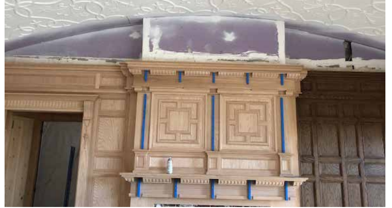
Fireplace partial wood décor installation
